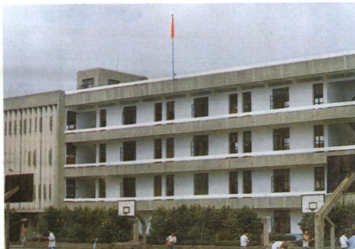
下：长河中学教学大楼。
