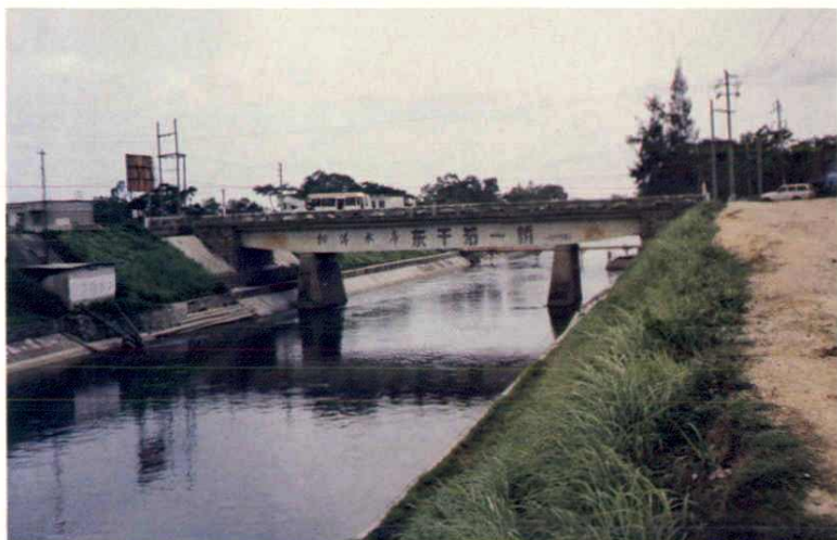
东干渠及公路桥
