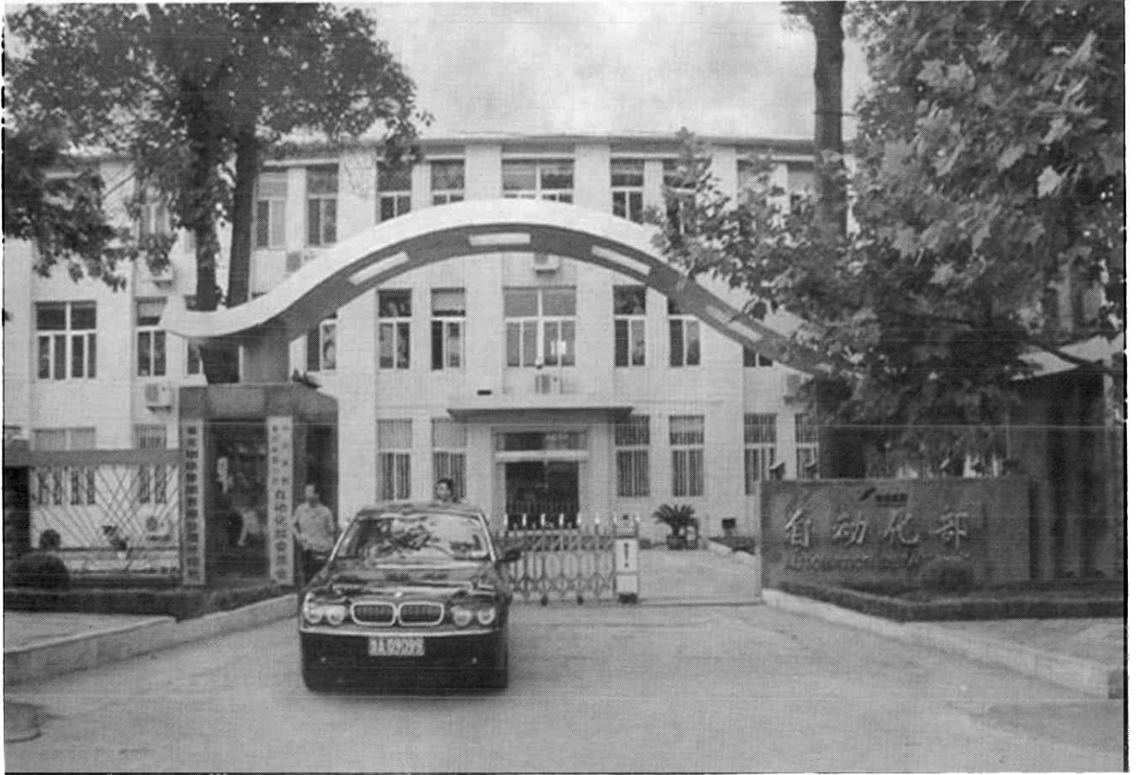
自动化部办公楼
