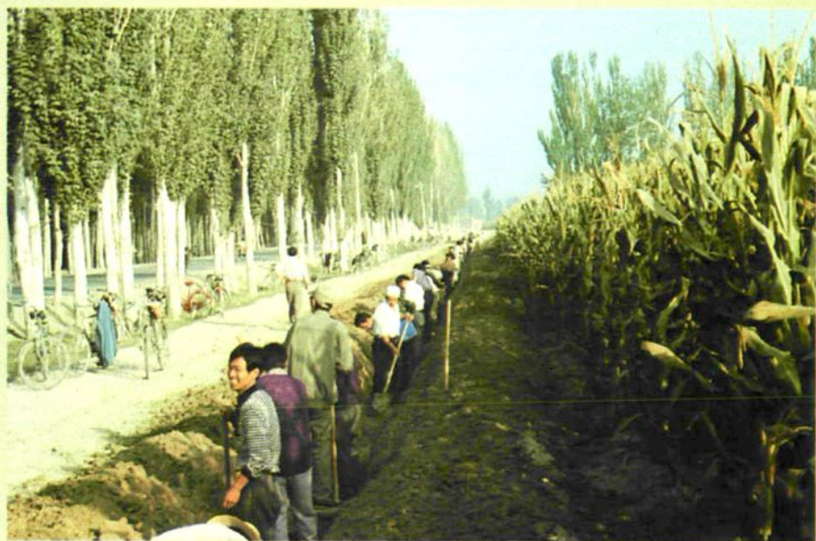
▷埋程控电话光缆线
