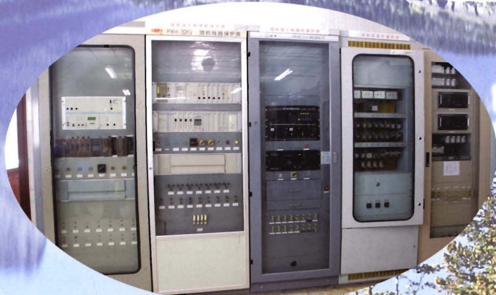
▲ 更新后的镜老厂线路保护装置
