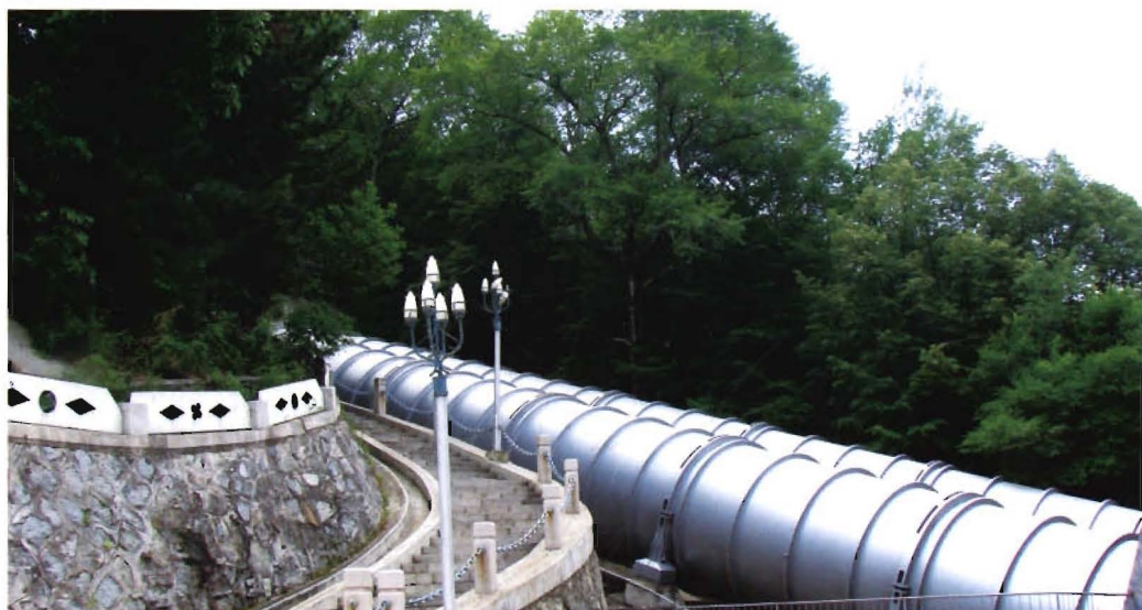
▲ 改造、维护后的镜老厂压力钢管
