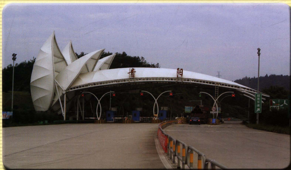
京台高速公路合铜黄段青阳出入口
