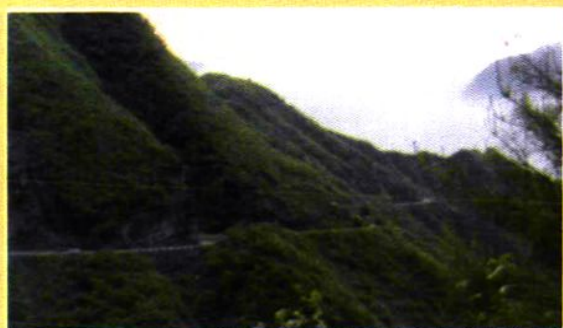
鹤南公路（鹤峰杨柳坪至南北镇） 大垭路段
