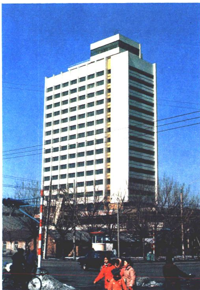
兴建中的辽宁省科技馆
