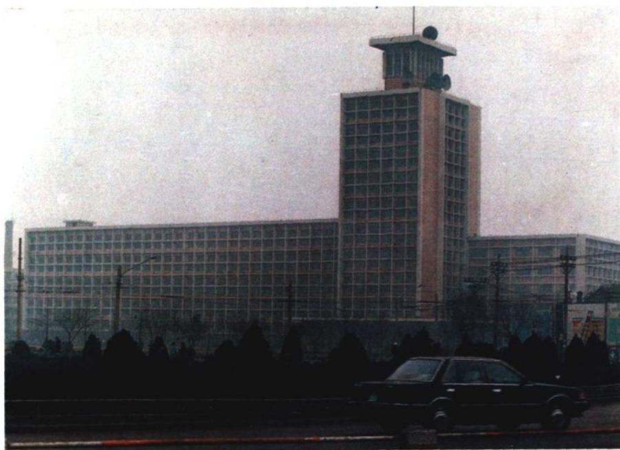
一九八三年新 建的沈阳市电信局 地址：市府大 路五段22号
