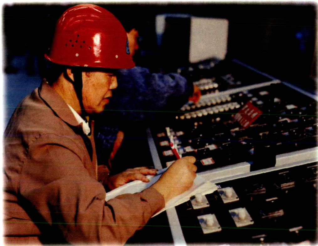
盘山发电厂 500 兆瓦机组启动试验
