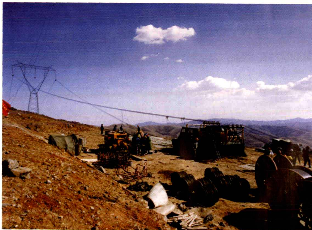
送变电建设者在山区进行500千伏输电线路放线施工
