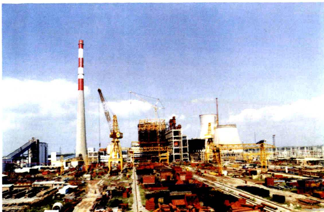
河北西柏坡发电厂建设工地及其设备组合场
