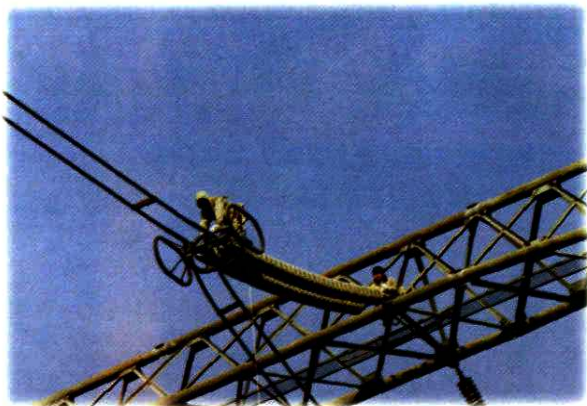
铁塔组立施工
