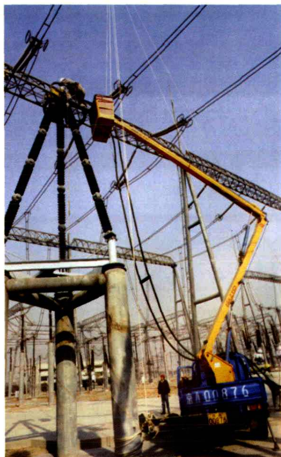
500千伏变电站设备安装
