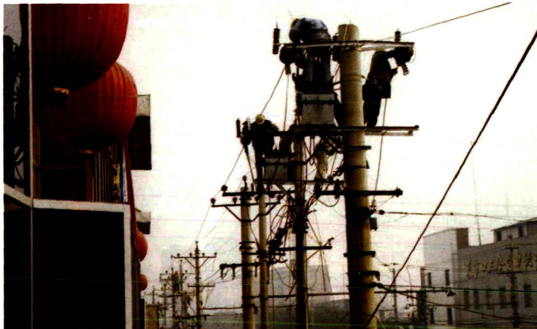
北京供电公司城网改造工程在闹市区紧张进行
