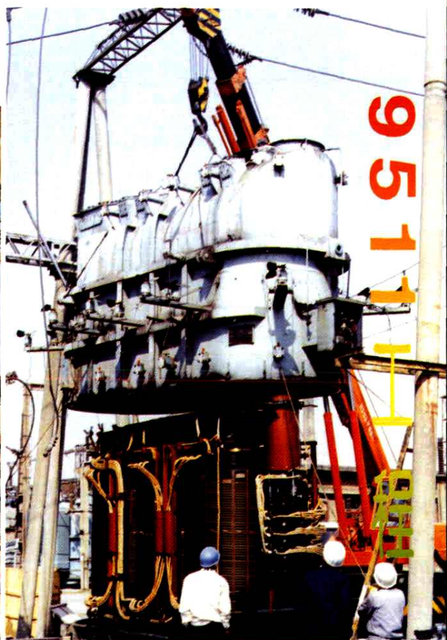
500 千伏主变压器安装扣罩
