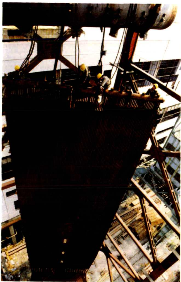
工人们在数十米高空作业，吊装锅炉水冷壁
