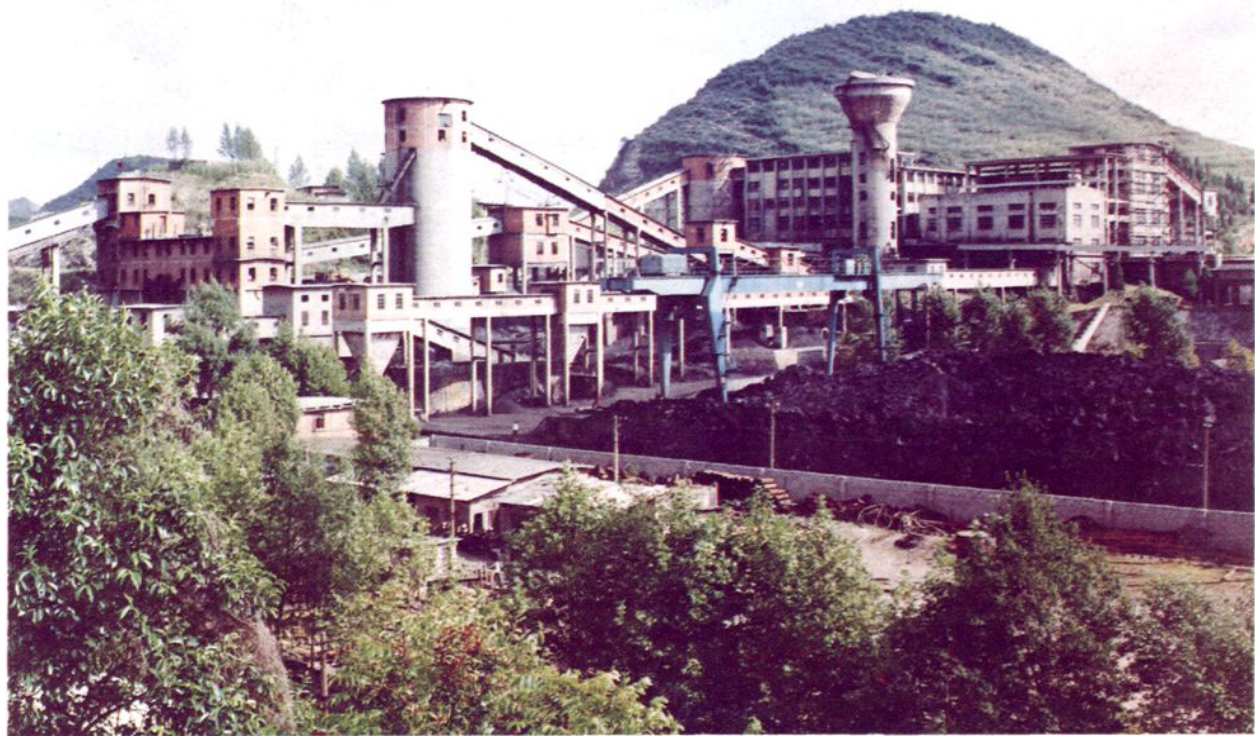
①地宗选煤厂全景
