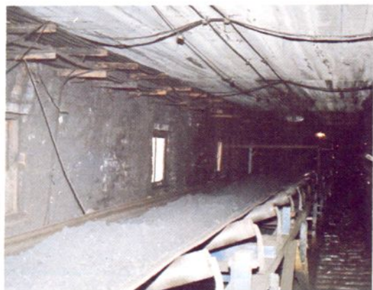
⑨ 原煤车间8号皮带走廊
