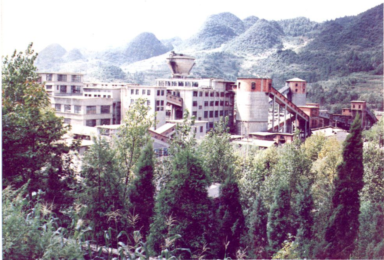
①地宗选煤厂全景
