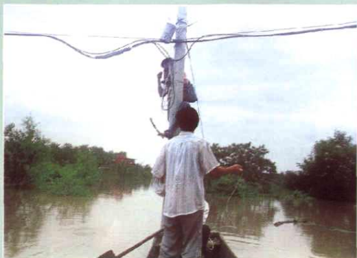
▲1987年，机线人员在特大洪灾中冒雨抢修被毁线路。
