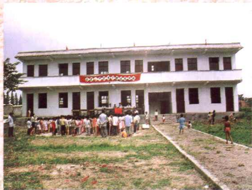
▲县局积极扶贫帮困，奎湖东胜小学教学楼于1996年建成使用。
