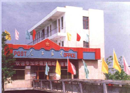
▲ 位于 205 国道旁的南陵县许镇邮电支局
