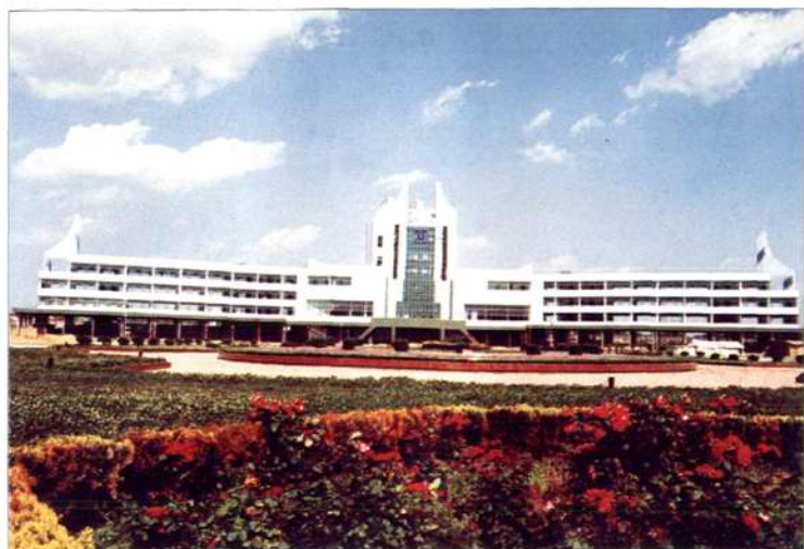
京九铁路商丘南站
