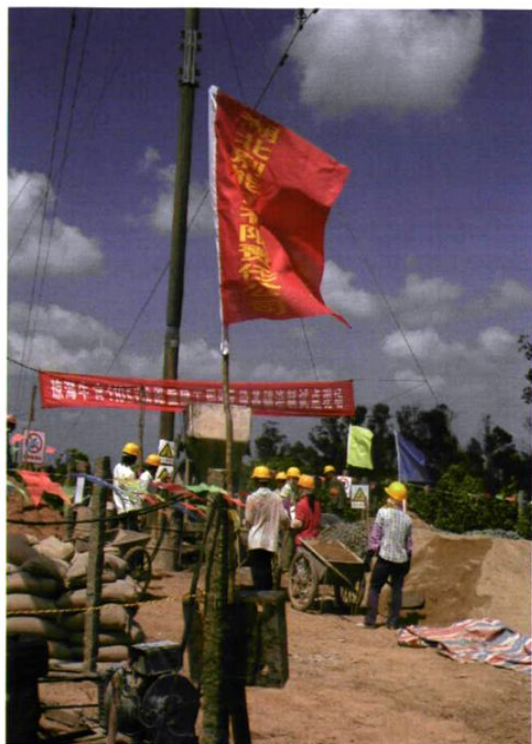
2006年，湖北荆能电力建设有限责任公司承建110千伏海南琼海牛路岭至官塘线路工程
