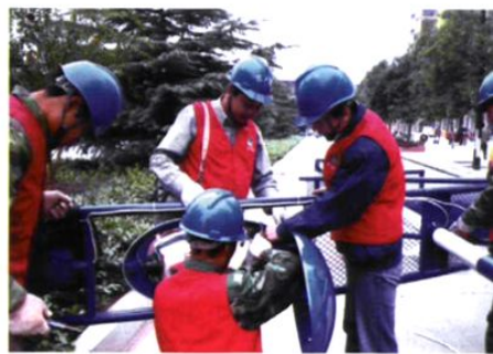
2007年4月，荆门市城区路灯管理局路灯红马甲检修服务队、党员突击队投入荆门城区路灯亮化工程建设
