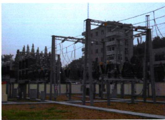
2007年8月25日, 湖北荆能电力有限责任公司承建110千伏钟祥双河变扩建工程
