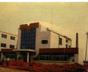
1995年, 荆门供电局电力设计所设计第一座变电站—金龙泉集团公司35千伏变电站
