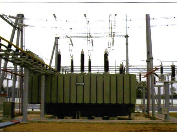
2007年10月1日，湖北荆能电力有限责任公司承建220千伏南桥变电站建筑安装工程和输电线路工程
