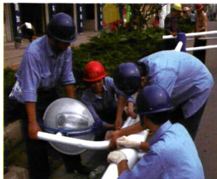
2005年8月，荆门市城区路灯管理局党支部开展“一个党员一盏灯，一个支部一面旗”的党先进性教育活动，全体共产党员参与荆门城区白云大道路灯安装工程建设
