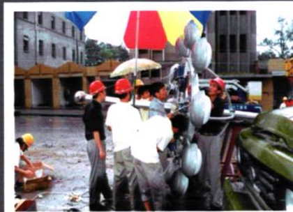
1999年8月，荆门供电局路灯分局安装荆门城区第一盏中杆灯——向东桥中杆灯
