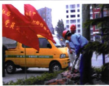
2007年9月，荆门市城区路灯管理局红马甲党员突击队和路灯检修服务队建设荆门城区虎牙关大道路灯亮化工程
