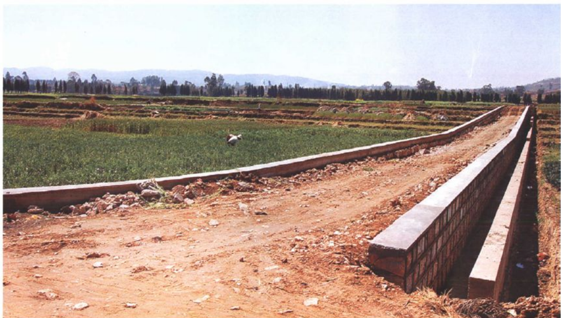
建设中的农业综合开发项目
