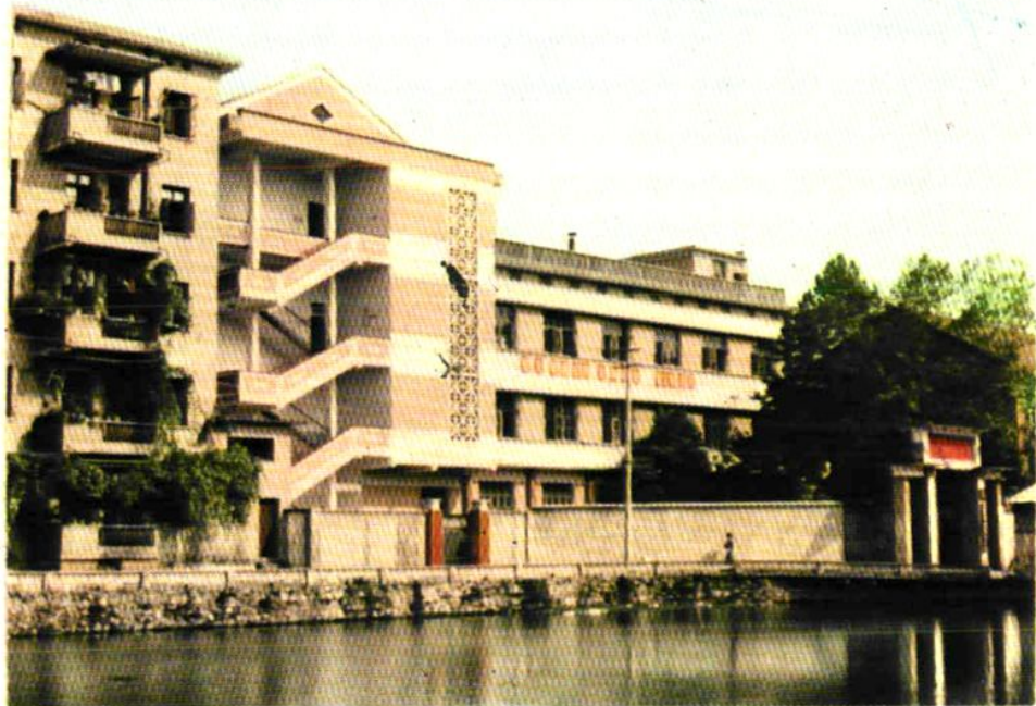
新建办公、车间综合大楼外景
