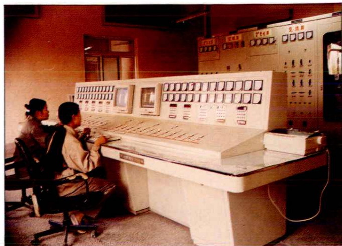
谷家台 35 千伏变 电所微机控制系统
