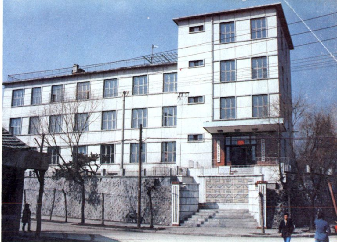
↑ (1985年建筑竣工1216平方米) 露天区卫生局、防疫站、妇幼保健 站办公大楼。
