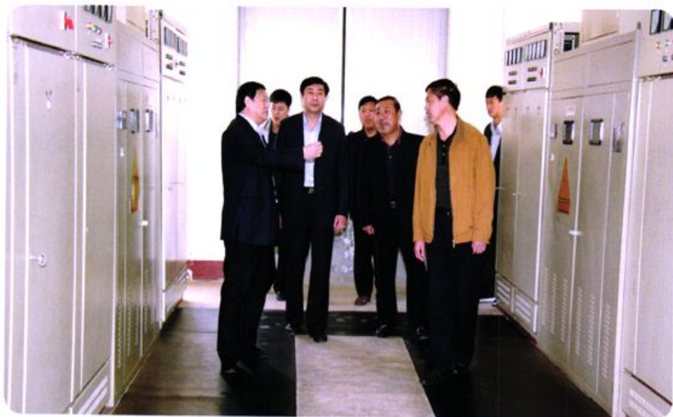
区政府、区政协领导在公司董事长孙茂齐陪同下视察芝阳水厂配电室
