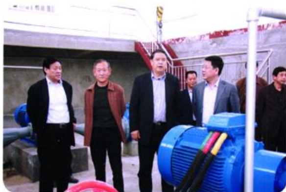
公司董事长孙茂齐陪同城市管理局、市自来水公司领导参观水厂泵房
