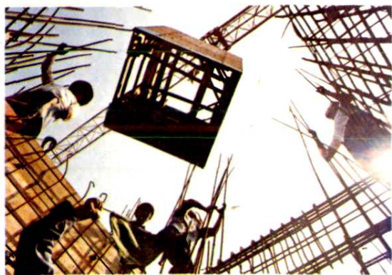
△ 高层楼宇在施工
