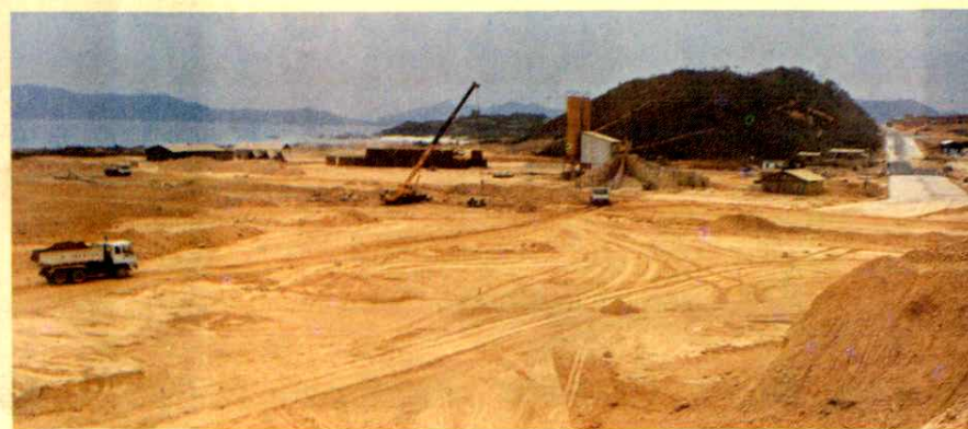
◁ 施工中的广东核电站
