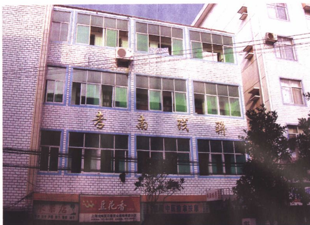
孝南区残联综合大楼
