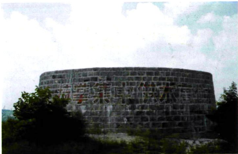
椅掌村供水塔
