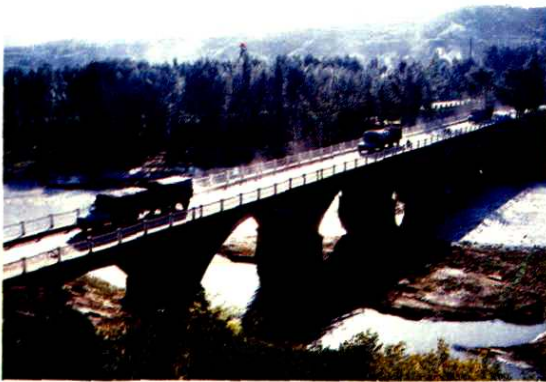
309 国道上的沁河大桥
