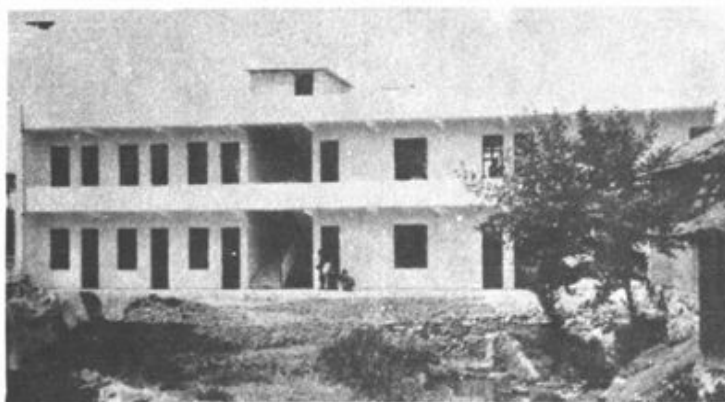
→ 黄冈县马庙镇成人文化 技术学校教学楼
