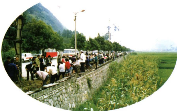
1991年9月，区政协委员提案“关于解决老城、场坝片区居民饮用水问题”得到落实，图为主管道开工现场。
