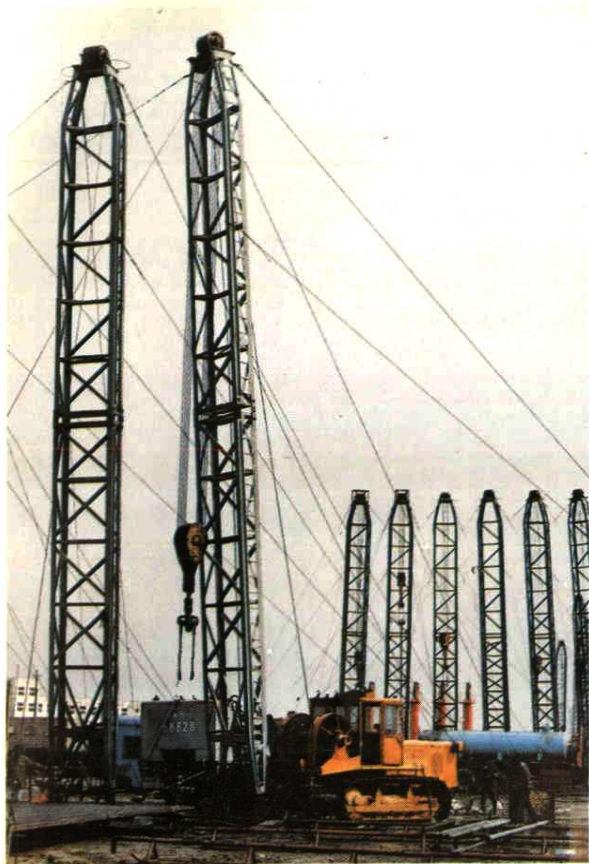
试油作业施工
