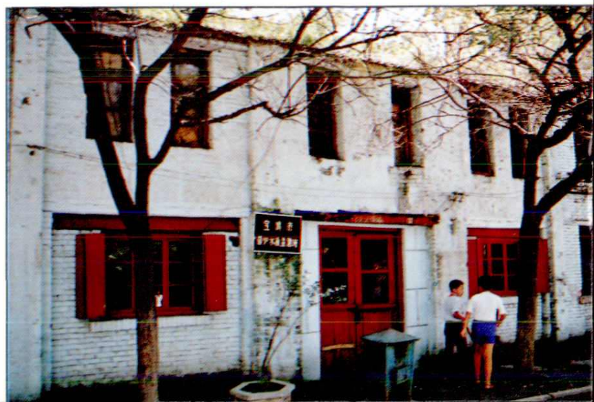
市锅炉水质检测站
