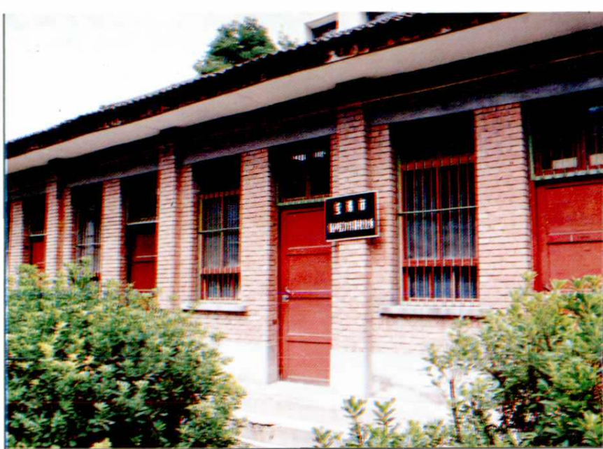
市锅炉压力容器检验所
