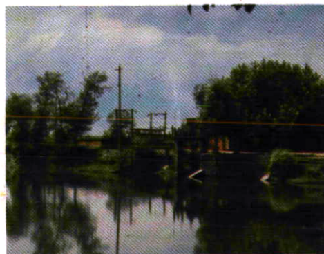
西沙湖电排站排水照
