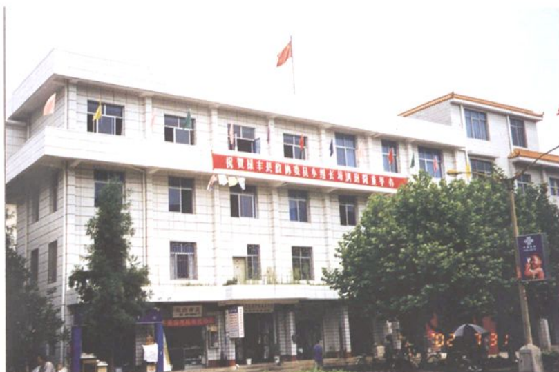
◀ 2001年3月扩建、修缮竣工的县政协办公楼。
