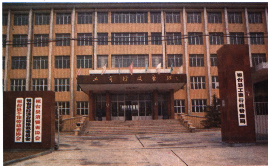
恒台县工商行政管理局办公大楼
