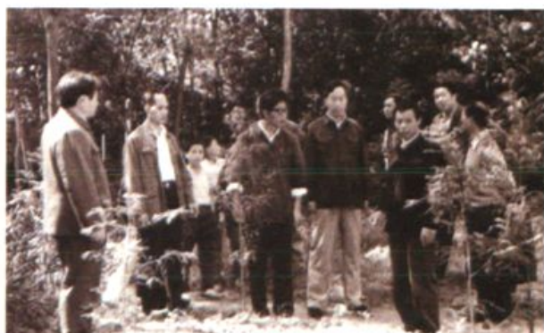
1986年，省水利水电厅厅长傅声远在湘阴县城西垵检查蓄洪安全建设。
