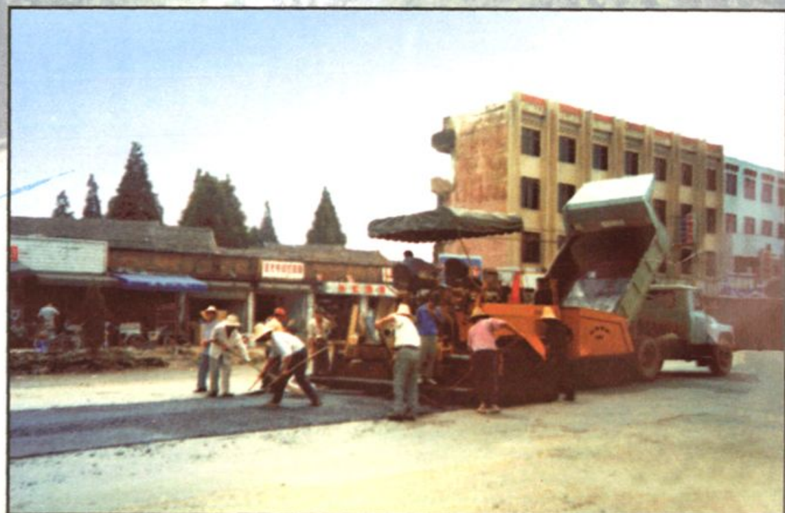
沥青混凝土摊铺机
