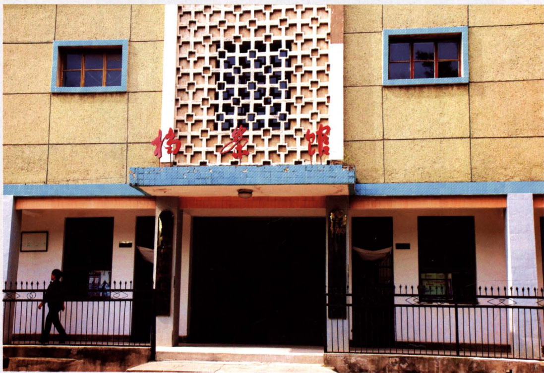
宜川县档案局（馆）楼正面
