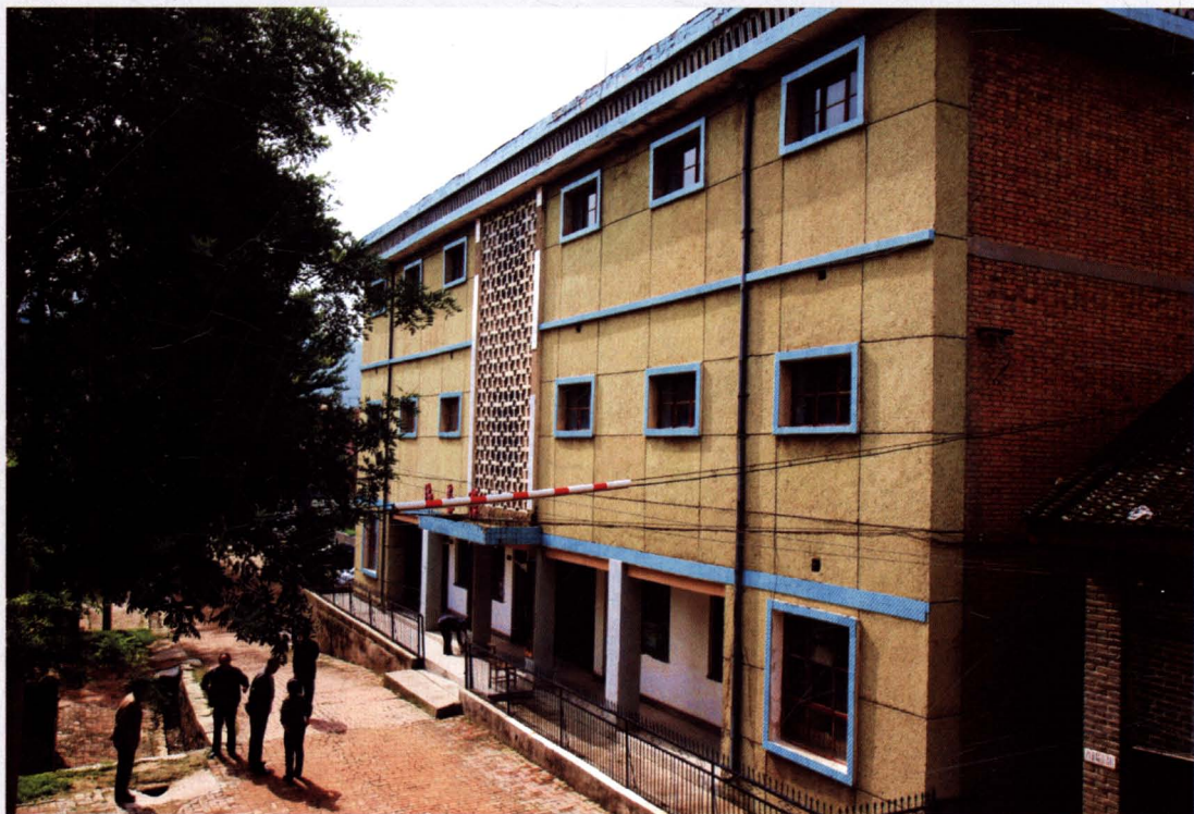
宜川县档案局（馆）楼全貌
