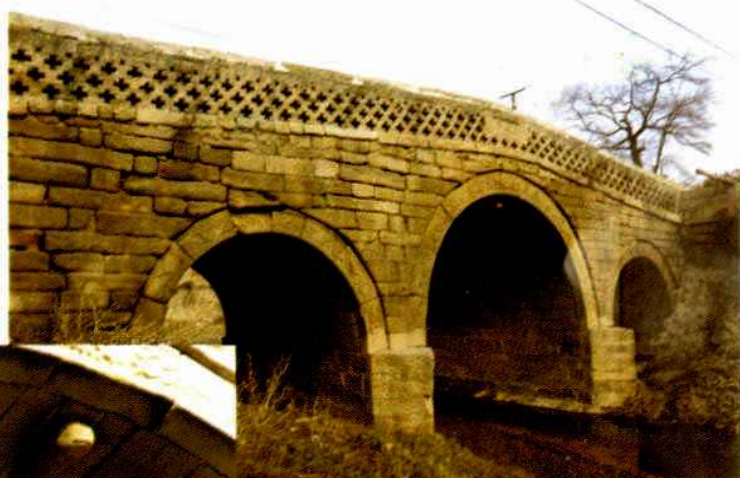
寿阳县安定桥
