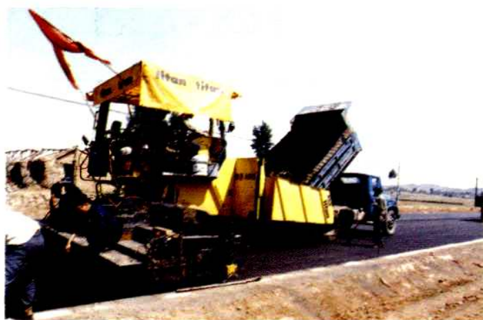
沥青路面施工
