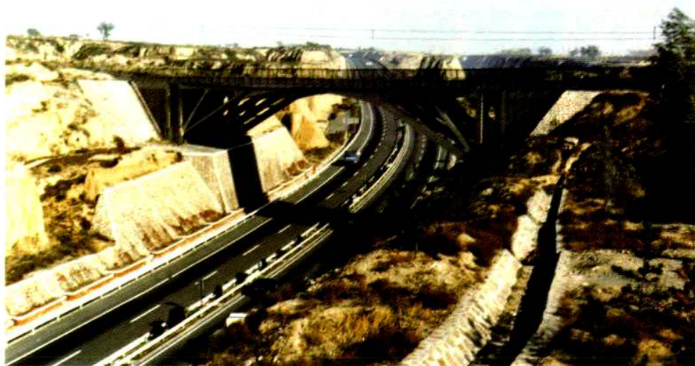
太旧路刚架拱立交桥
