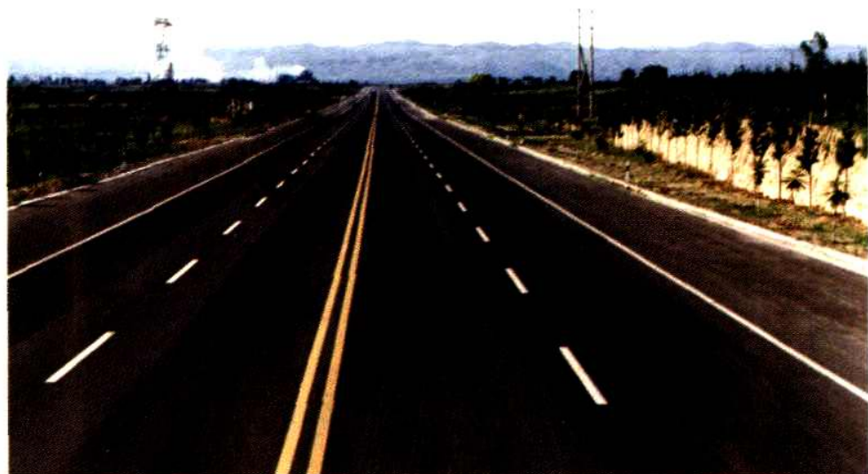
宽阔的县乡公路（榆次太旧路连接线）
