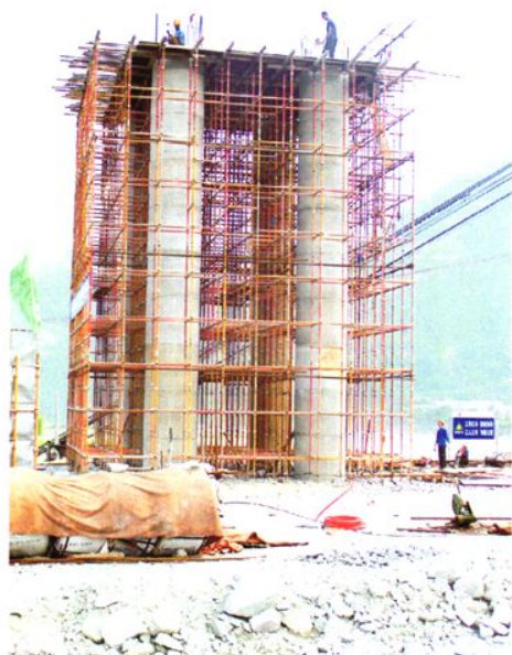
正在建设中的大岗山水电站施工现场
