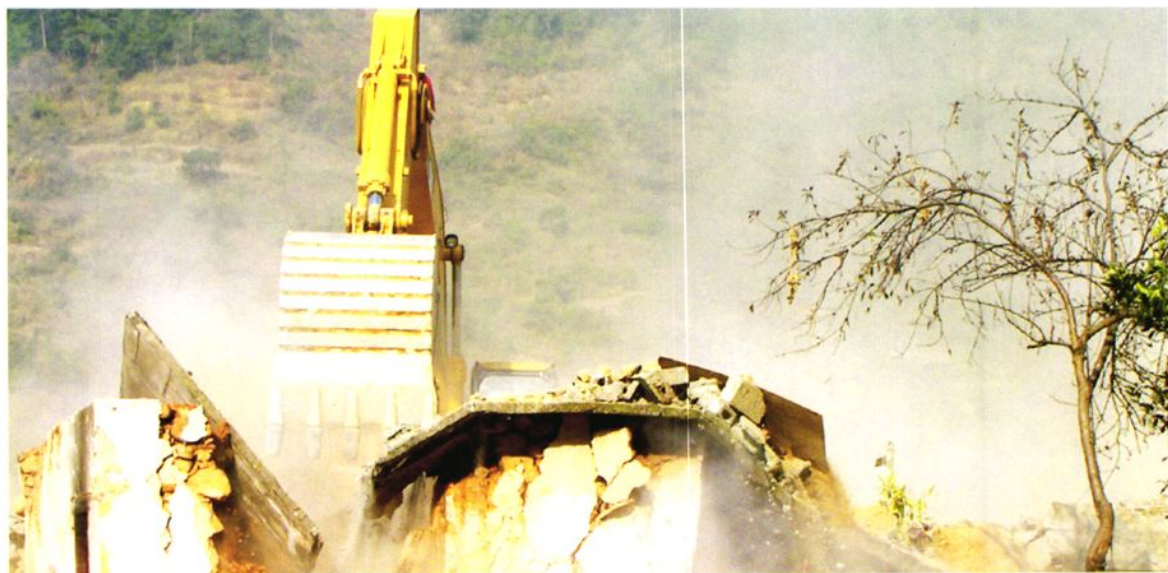
移民拆迁现场
