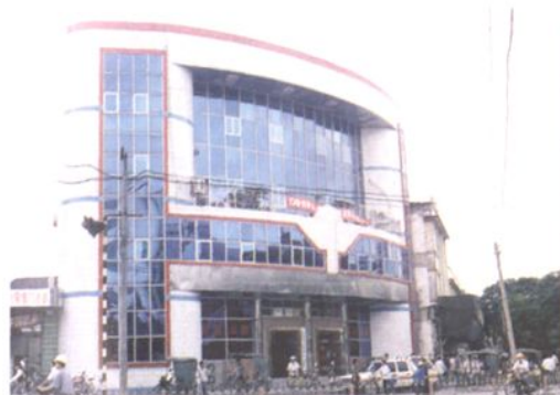
灵山县邮电营业大楼
