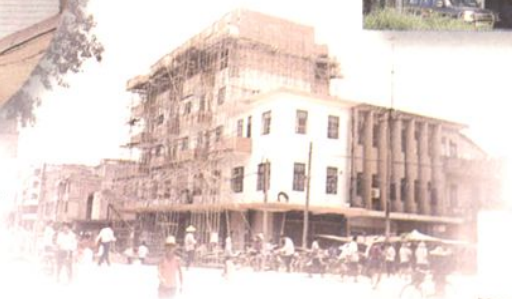
建设中的武利邮电支局
