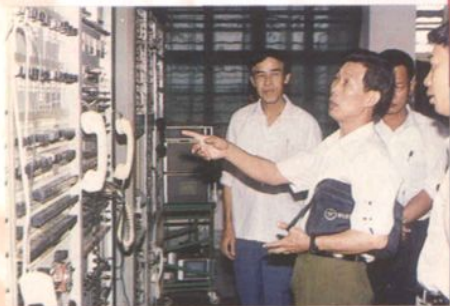
1992年6月，区局电信处原副处长王云杰（左二）在灵山县原局长戴永遂陪同下检查载波机房。
