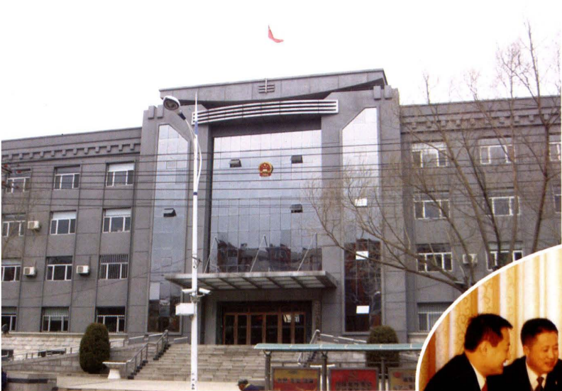
区人民检察院办公楼
