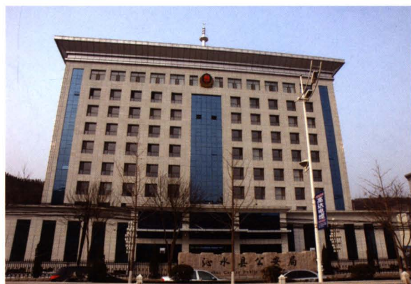
沁水县公安局办公大楼
