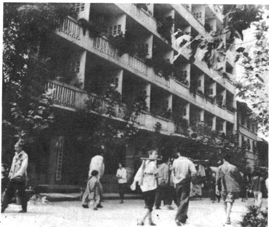
县供销社办公大楼
