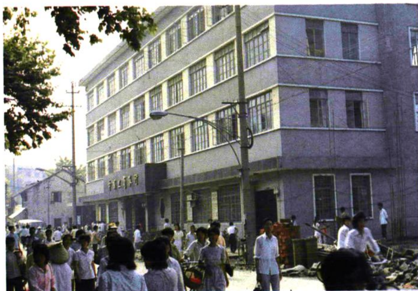
中國工商銀行溧陽縣支行辦公大樓，84年分設後， 與縣人民銀行同一幢樓辦公。
