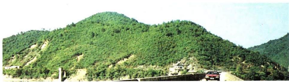
坝顶，北端即姥山
