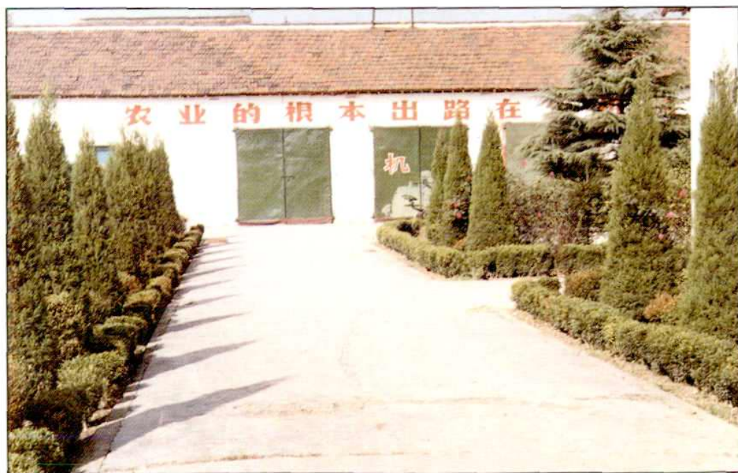
昆山市花桥镇顺杨农机队机库
