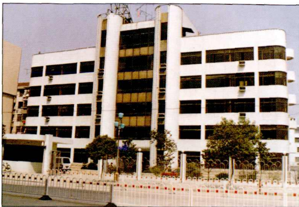
昆山市水利局办公大楼
