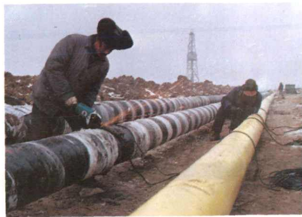
长输管道焊接安装
