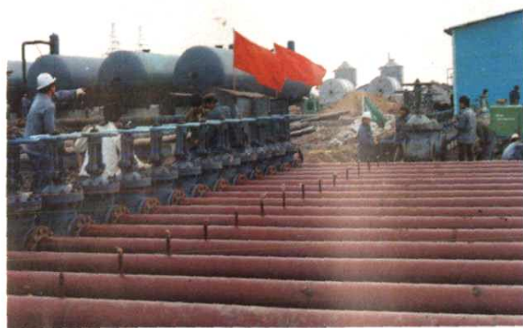
原油集输工艺安装
