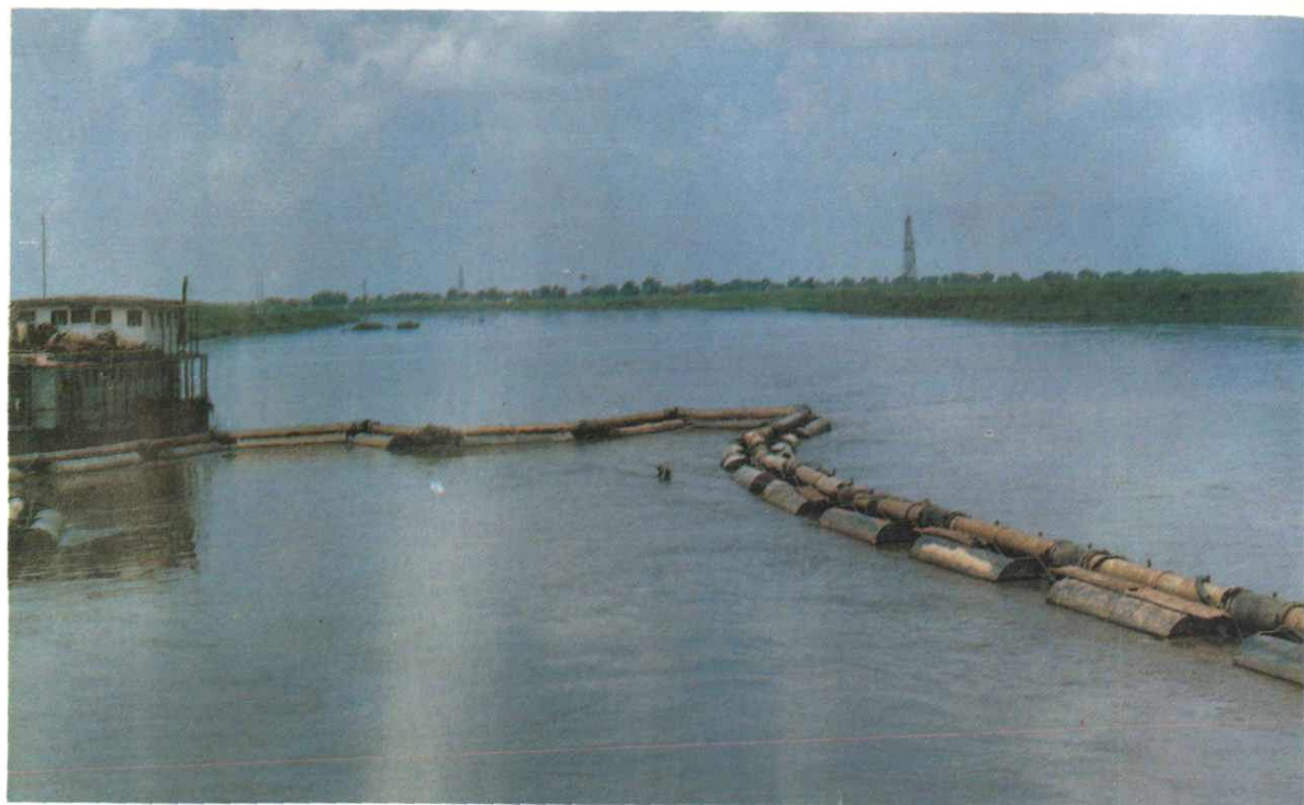
河道穿越施工
