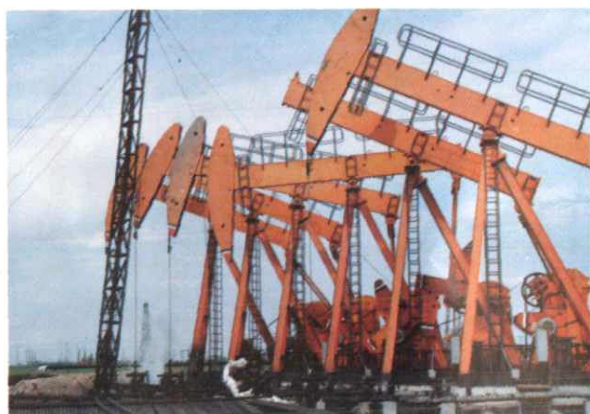
丛式井口工艺安装
