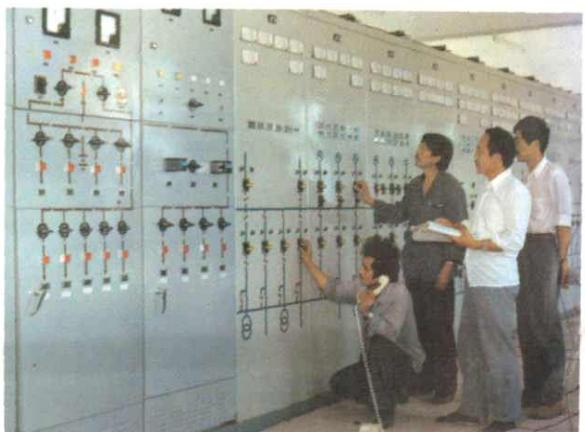
变电所整体调试
