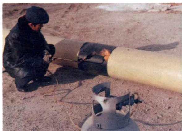
副射胶联聚乙烯热收缩带夹克管线补口工艺
