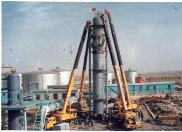
原油稳定塔吊装
