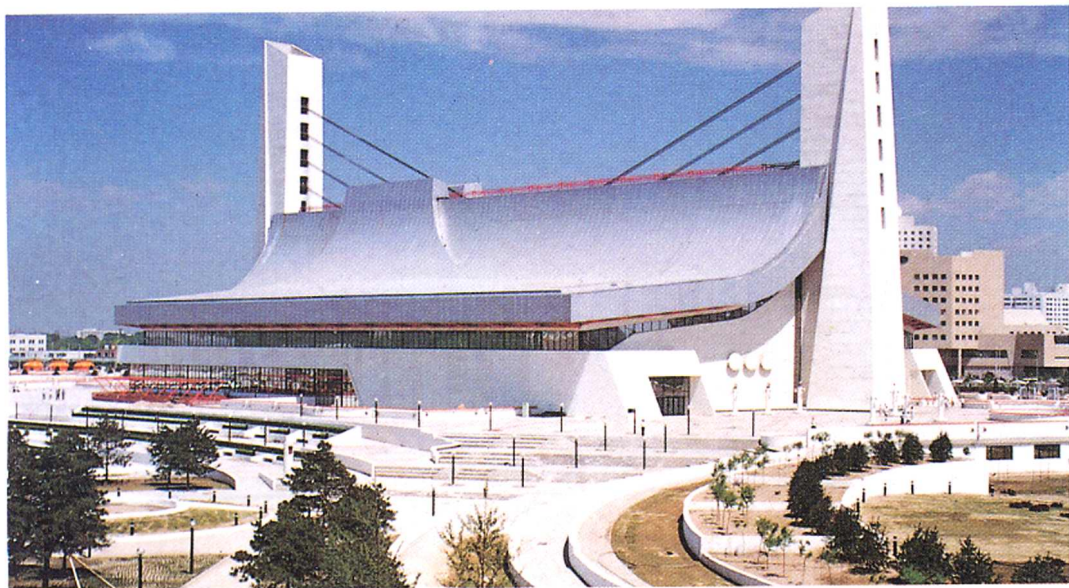
● 国家奥林匹克体育中心英东游泳馆1989承担项目：通风、空调、冷冻、锅炉、变配电、工艺管道
