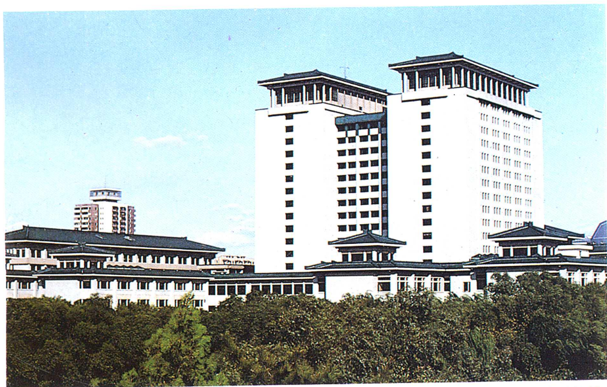
● 北京图书馆新馆(1987) 承担项目：通风、空调、动力、变配电、电梯、书刊传送机械、消防系统
