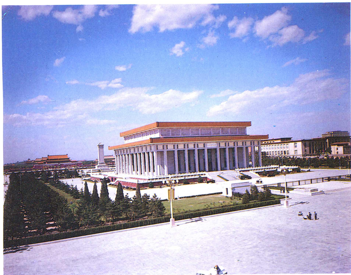
● 毛主席纪念堂(1977) 承担项目: 通风、空调、冷冻、热力点、变配电、动力、透平机车间 (纪念堂配套项目)
