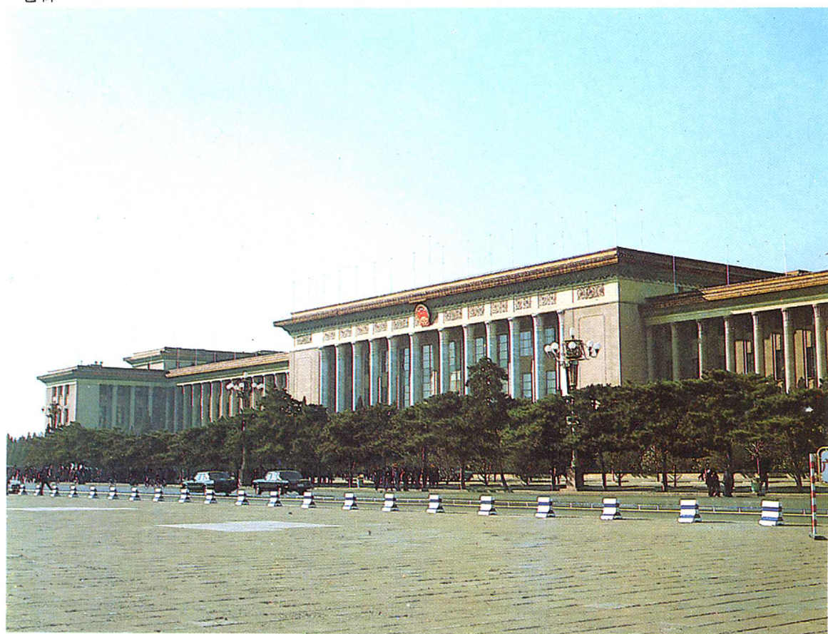
● 人民大会堂(1959) 承担项目: 通风、空调、冷冻、变配电、电缆、动力、电梯、煤气设备
