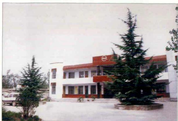
矿管所办公楼
