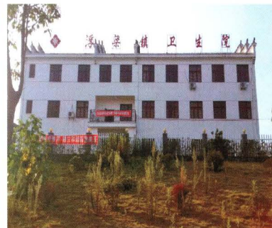
浮梁镇卫生院
