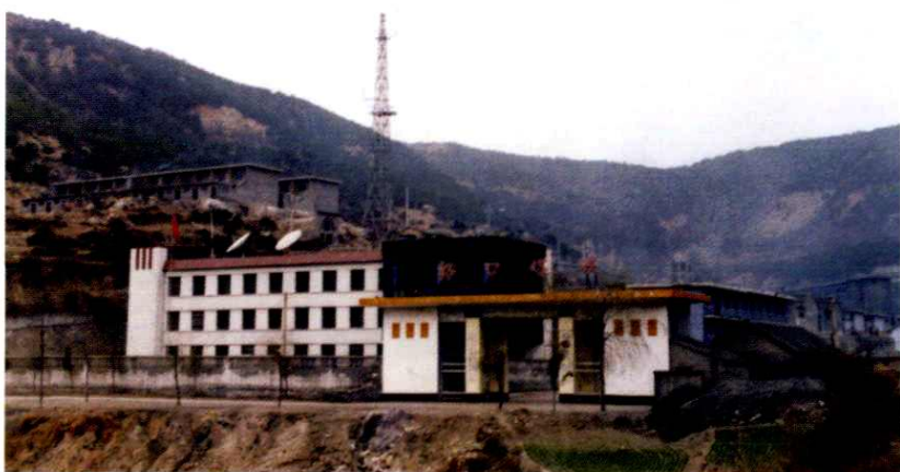
市豁口煤矿(1998年)
