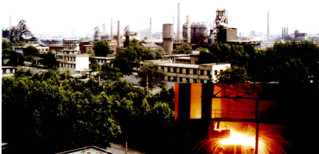
临汾钢铁公司(1998年)
