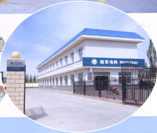
规范化供电所
