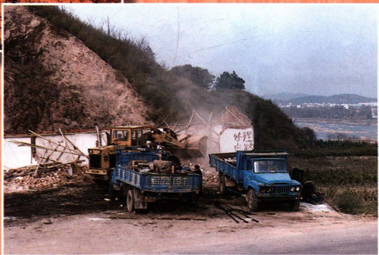
须江镇清理土地市场，拆除 违法占地建筑
