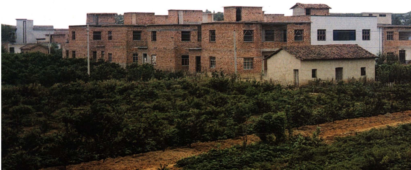
峡口地山岗村居民建房上山岗
