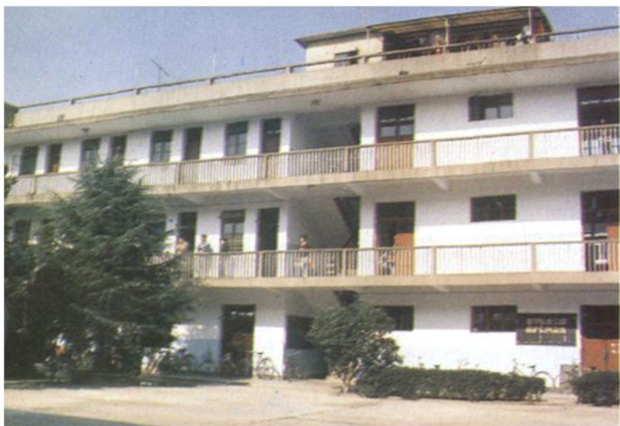
市卫生进修学校教学楼
