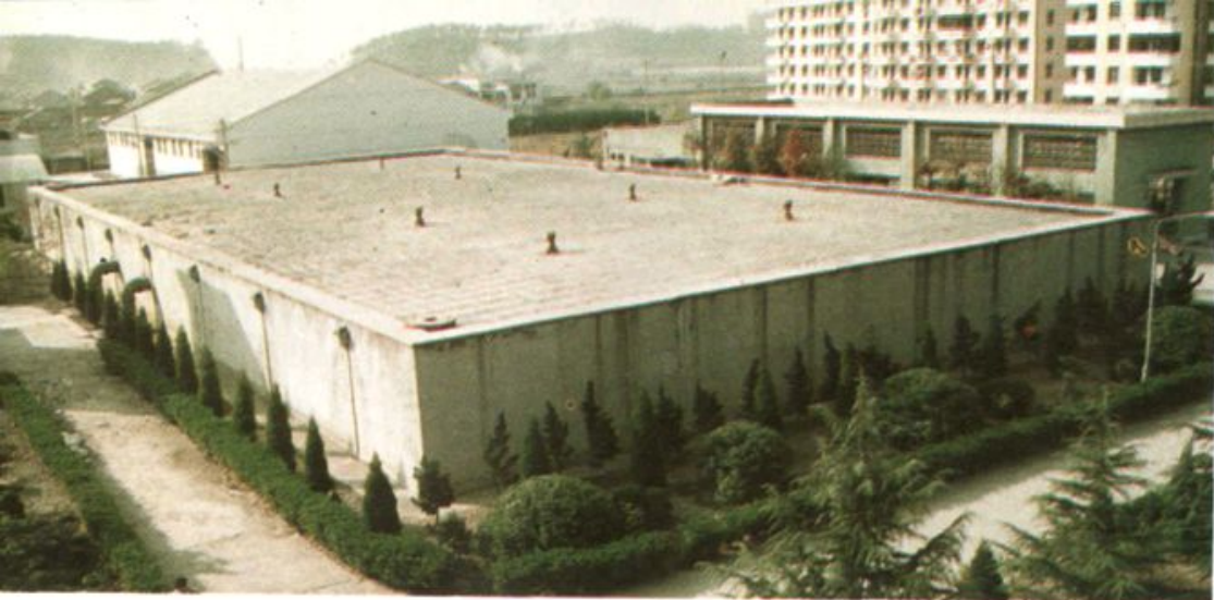
市第二水厂清水池
