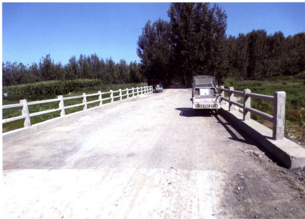
图 A-19 2010 年，村东新建跨越韩刘引黄干渠大桥，承载 100 吨以上 韩传龙 2016 年 8 月摄
